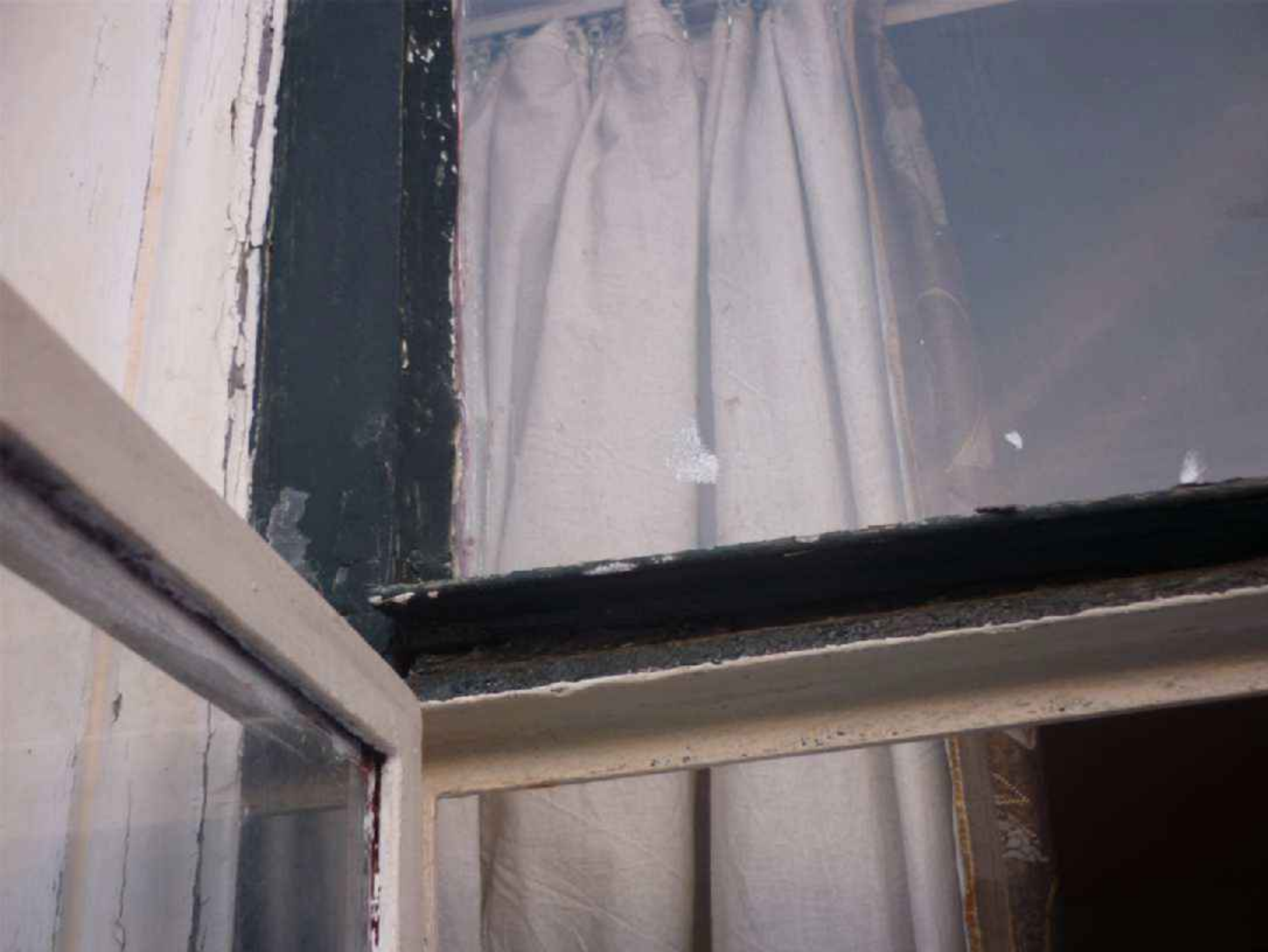
Stoeltjesprofielen en enkelglas. De indeling van de voormalige schuiframen is gevolgd. Het staal is plaatselijk te ver gecorrodeerd en er is geen kierdichting aanwezig.
