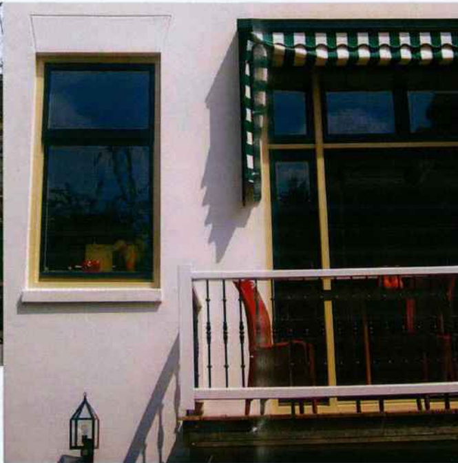
referentie gevelvenster, vast bovenlicht en naar binnendraaiend raam (Van Limburg Stirumstraat, 2007)
