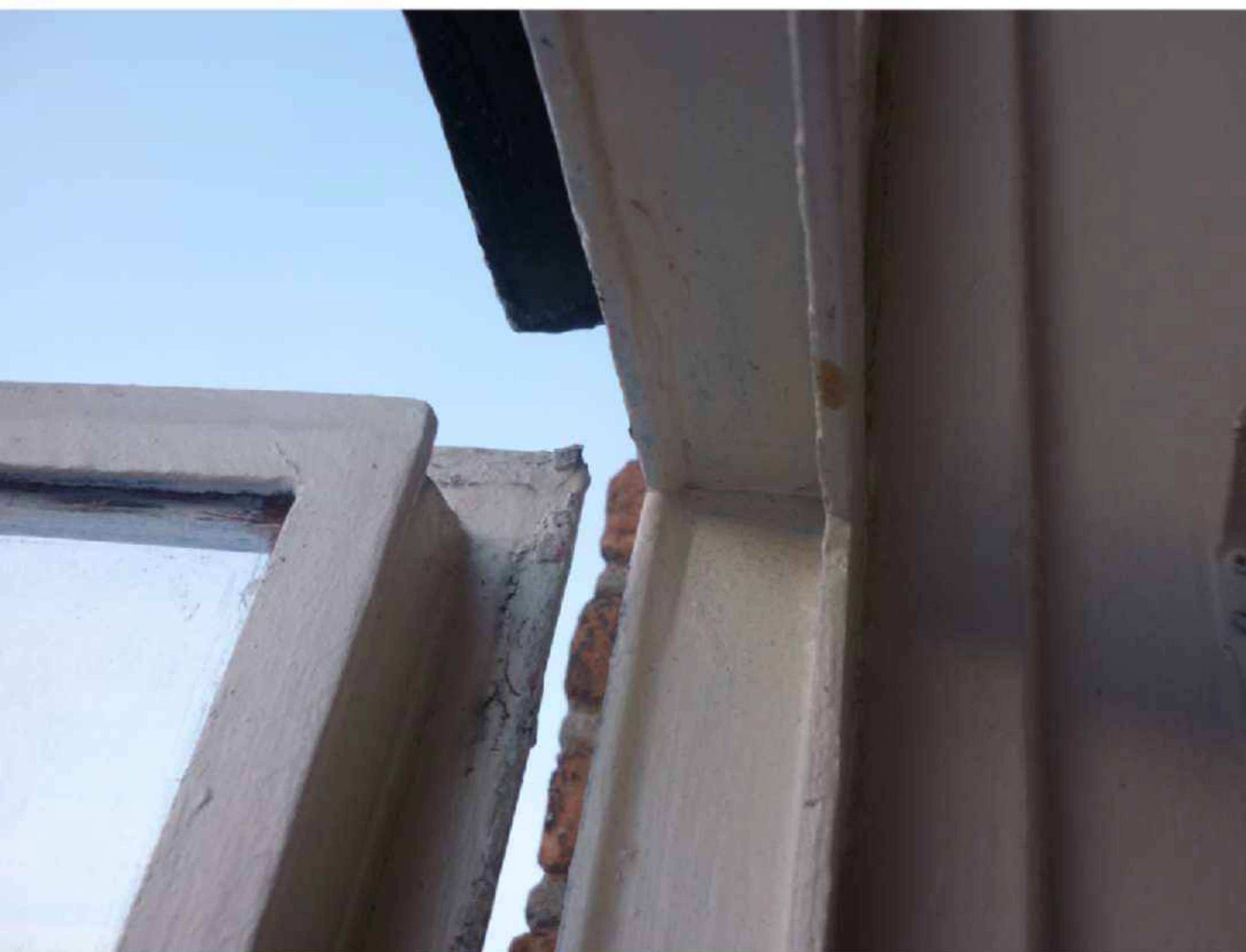
Stoeltjesprofielen en enkelglas. De indeling van de voormalige schuiframen is gevolgd. Het staal is plaatselijk te ver gecorrodeerd en er is geen kierdichting aanwezig.
